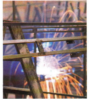
Schweißarbeiten am Stahlrohrgewölbe.
