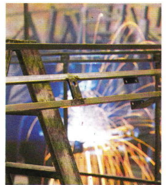
Schweißarbeiten am Stahlrohrgewirpe.
